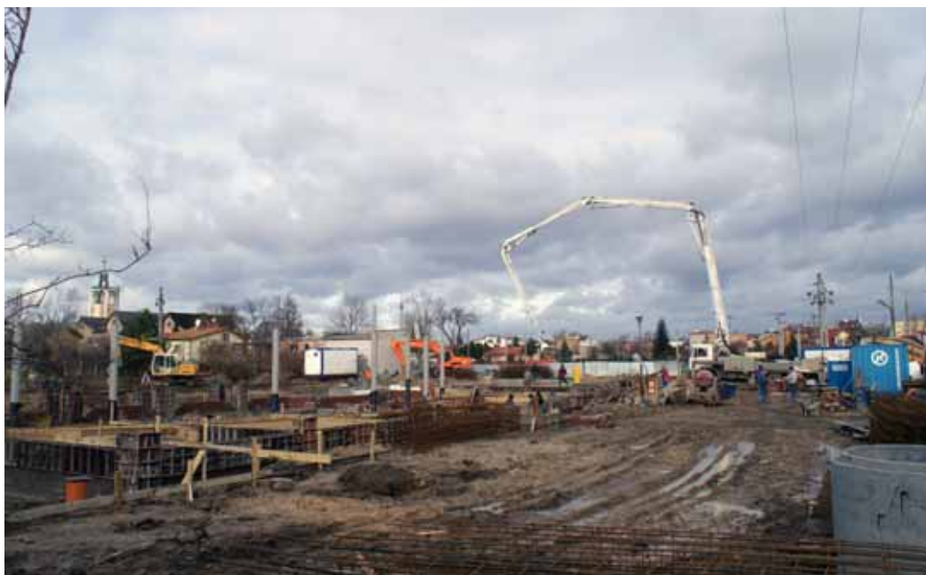
Plac budowy przypomina scenę batalistyczną
