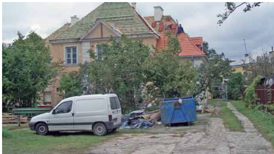
Trwają jeszcze prace przy wymianie dachu
