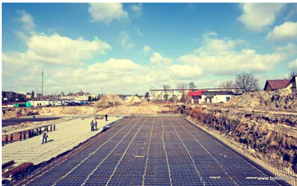
Po wykonaniu zbrojenia zostanie wylana płyta fundamentowa
