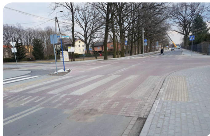
Przykładowe „wywyższone skrzyżowanie”, zrealizowane przez Powiat w Wołominie
