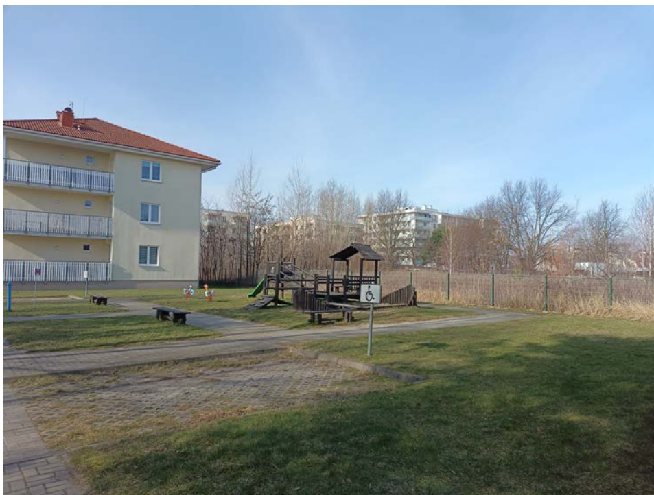
Fot. 2 Zabudowa wielorodzinna i obszar zadrzewiony i zakrzaczony – widok od strony ulicy Powstańców (materiał własny)
