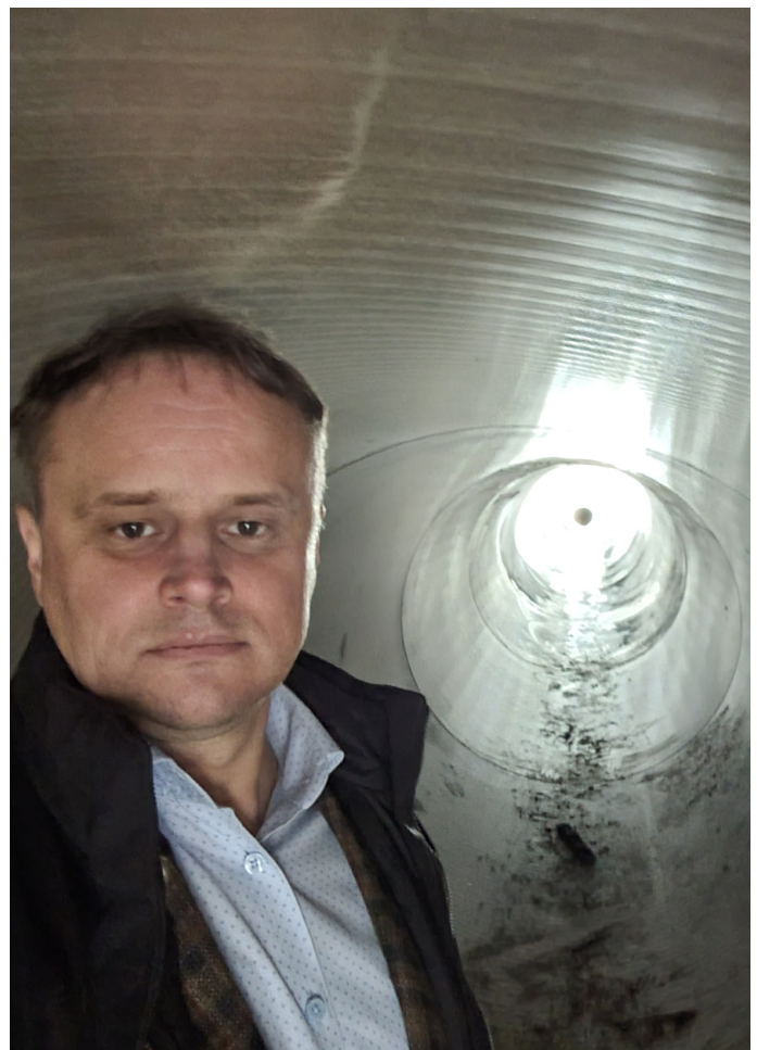
Zdjęcie z budowy podziemnego zbiornika wód opadowych z ul. Piłsudskiego od ul. Targowej do Kołłątaja. dwa równoległe zbiorniki z rur GRP ŚREDNICY 180cm
