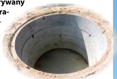
Fundament pod wieżę: średnica 2,5 m, głębokość 7,8 m
