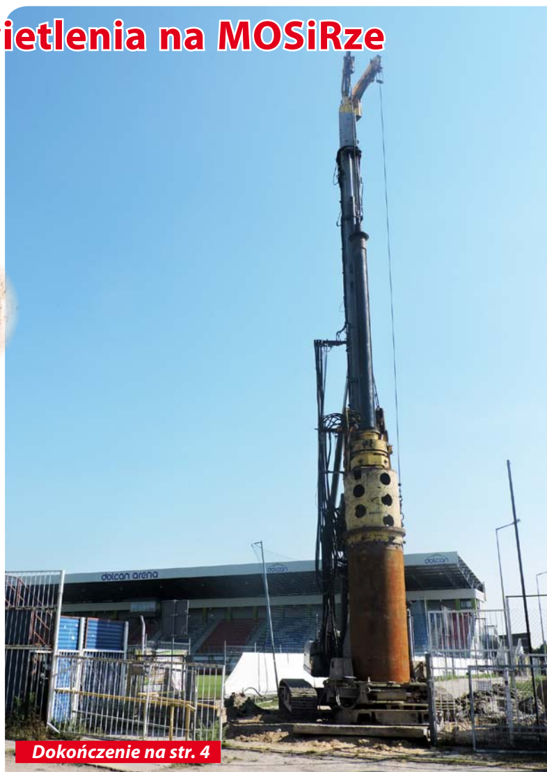
Fundament pod wieżę: średnica 2,5 m, głębokość 7,8 m
