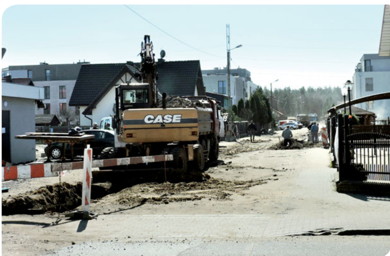
Roboty drogowe na ul. Podleśnej
