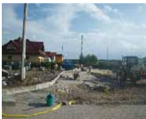
Ulica Kościelna - w trakcie
