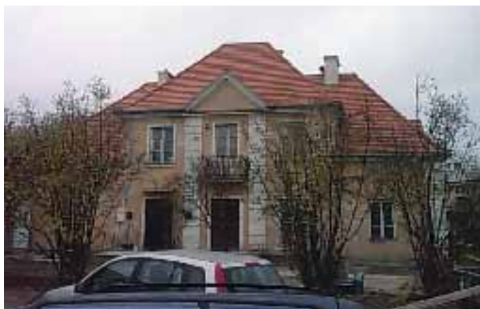
Zabytkowa willa Alina (siedziba MOK-u) po remoncie (etap I)
