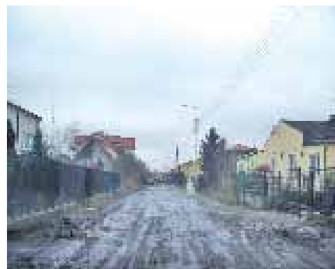
Ulica Torfowa - w trakcie
