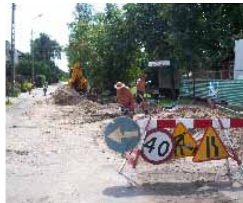
Budowa wodociągu w ul. Gałczyńskiego
