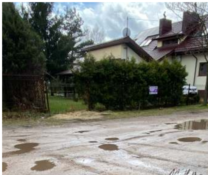
Budowa ul. Cichej potrwa do 6 miesięcy
