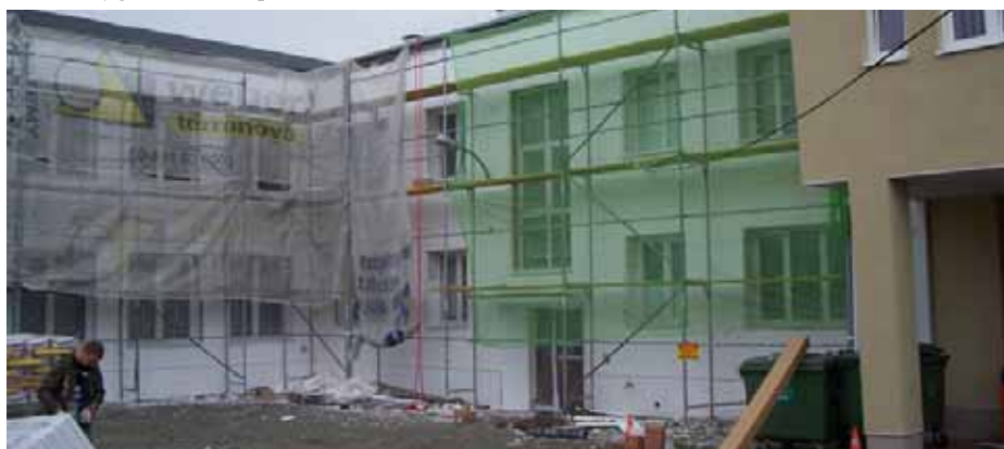
MO Obecnie trwa termomodernizacja od strony dziedzińca
