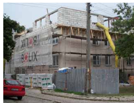
Nadbudowa budynku przy ulicy Legionów 16
